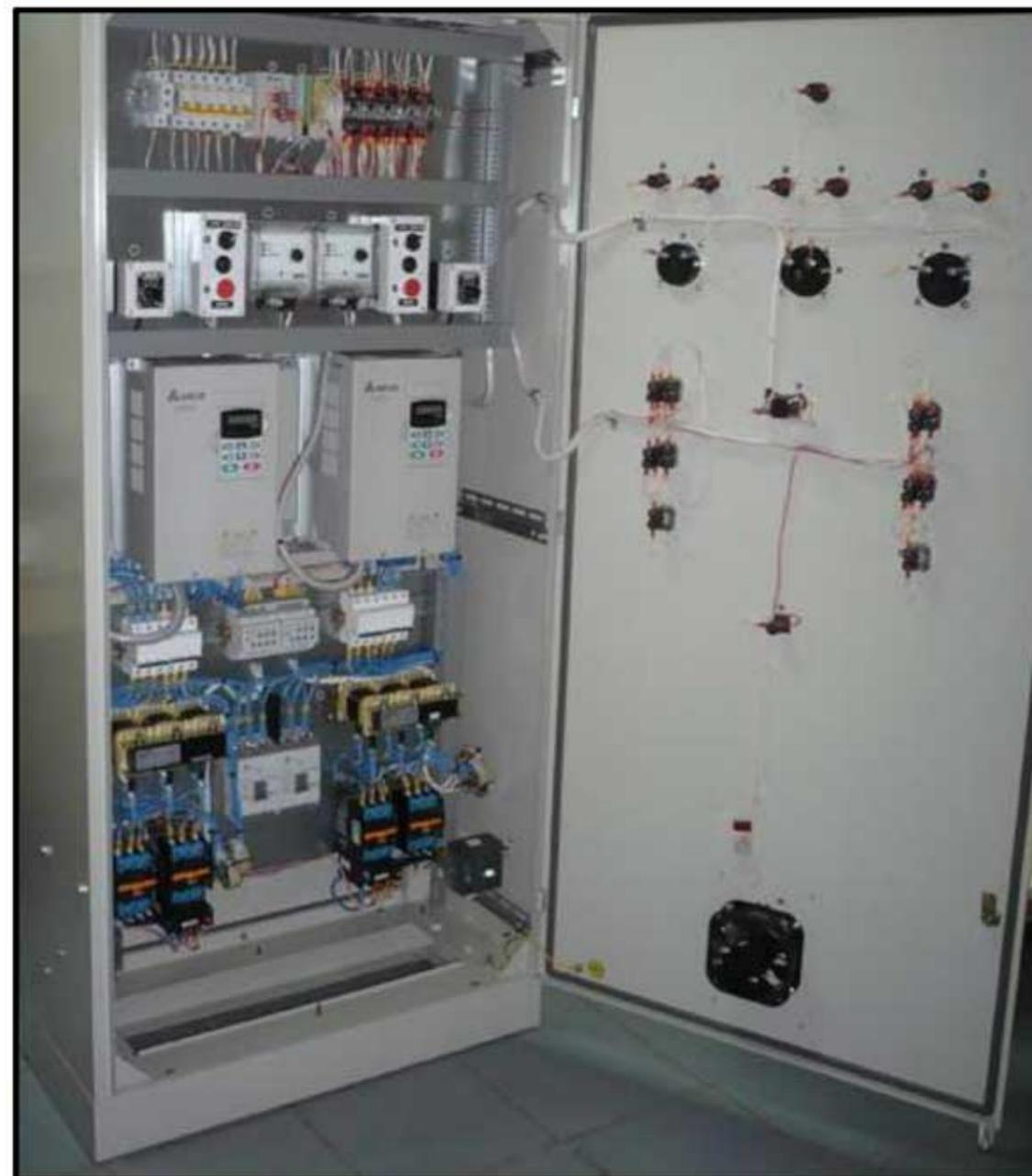
Преобразователи частоты VFD-F в шкафу управления
