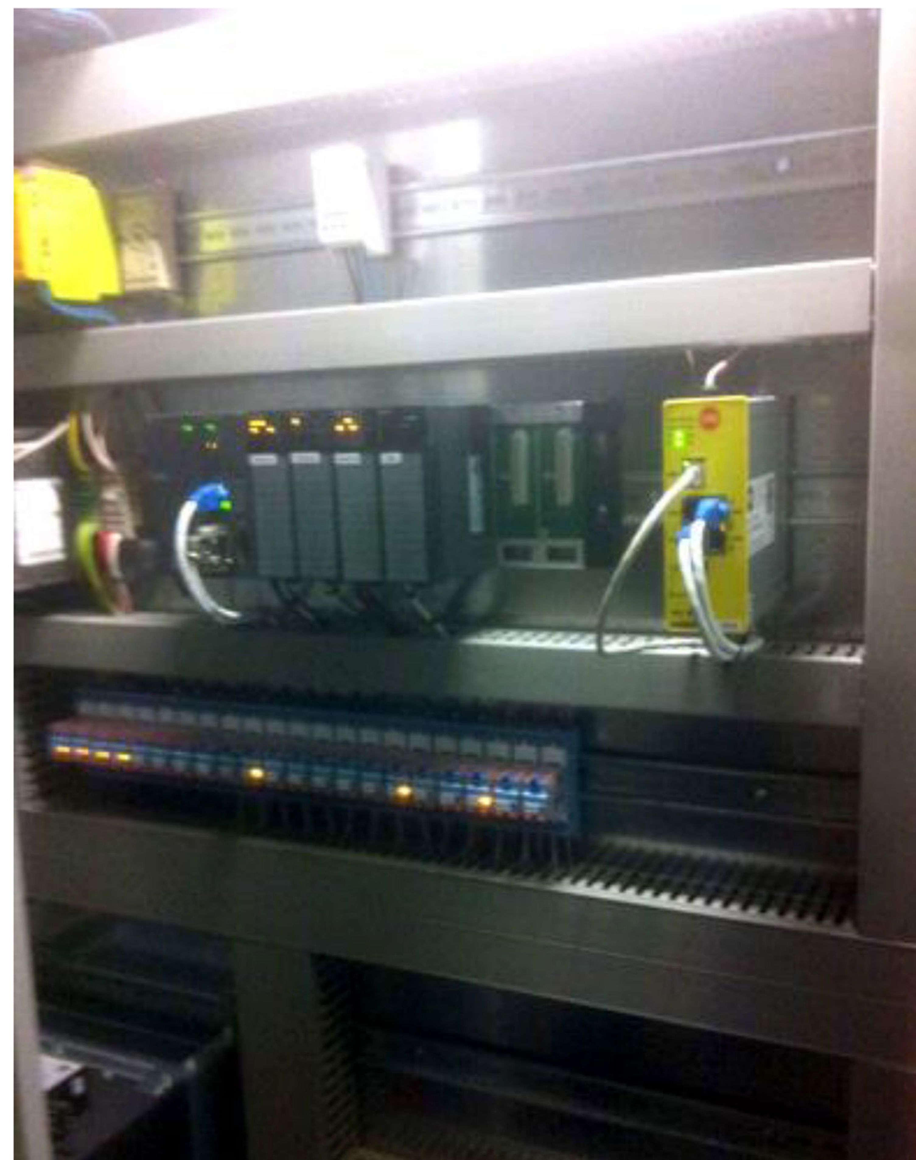
Модульный контроллер Delta Electronics серии AH500 с модулями расширения
