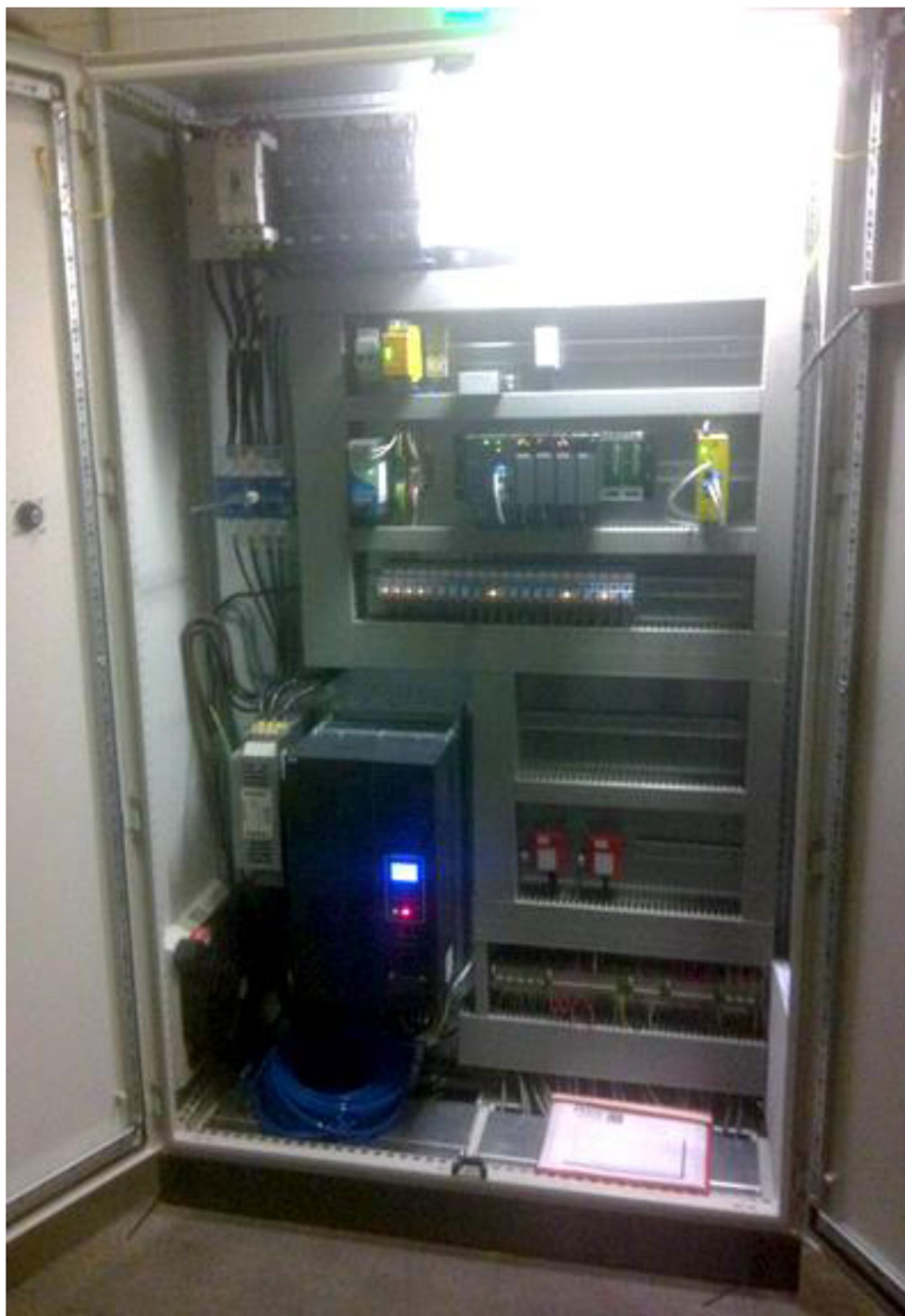
Шкаф управления с преобразователем частоты Delta Electronics серии C2000 (внизу слева)
