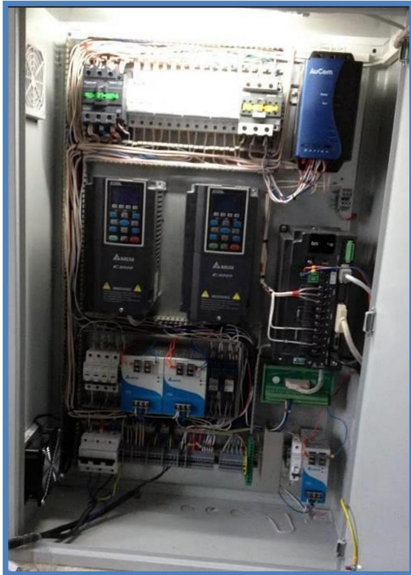
ПЧ DELTA, сервопривод DELTA и УПП AUCOM в шкафу управления станком для производства кронштейнов ККУ
