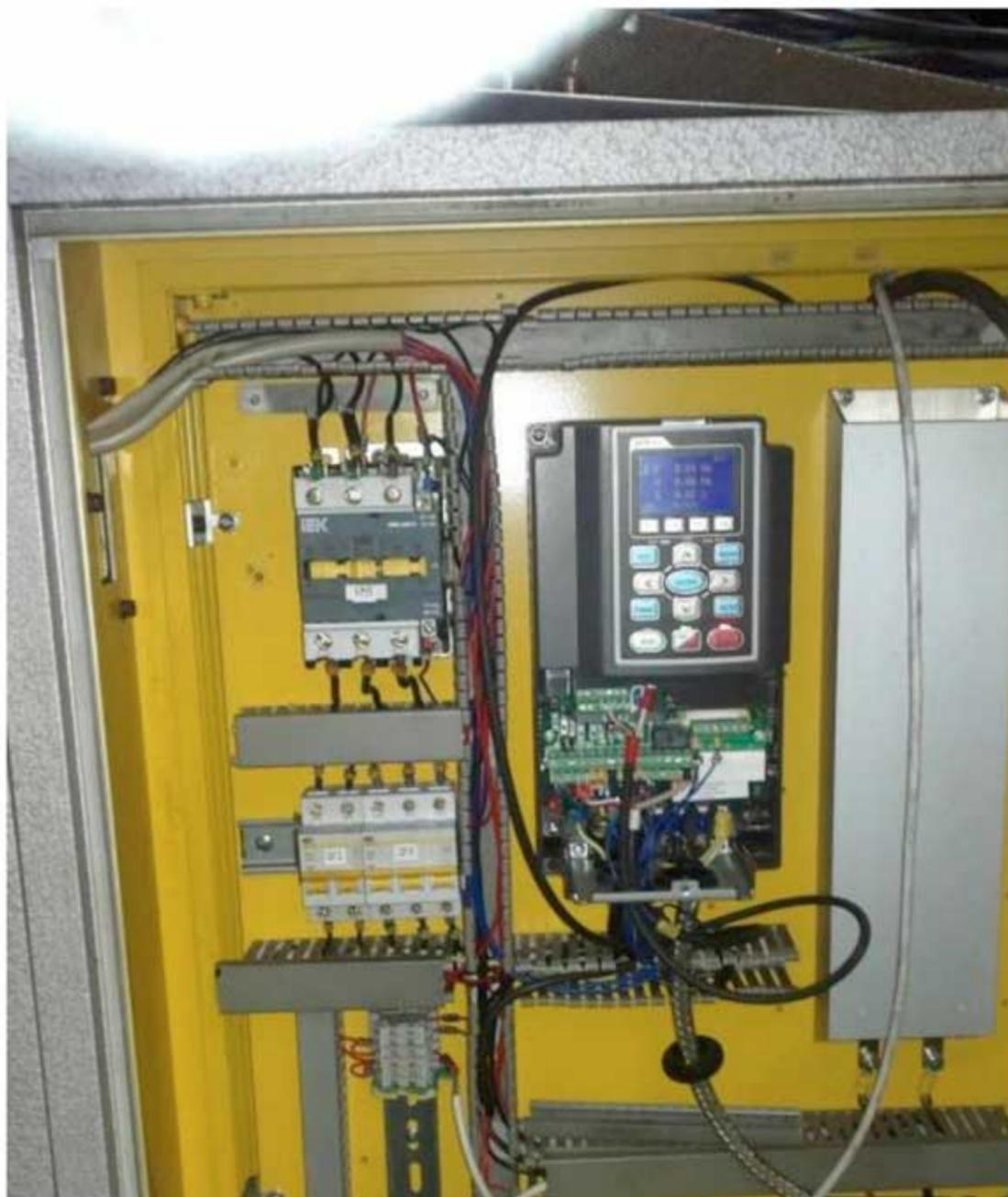
Для управления скоростью шпинделя используется преобразователь частоты Delta Electronics серии C2000, который позволяет бесступенчато изменять частоту вращения шпинделя.
