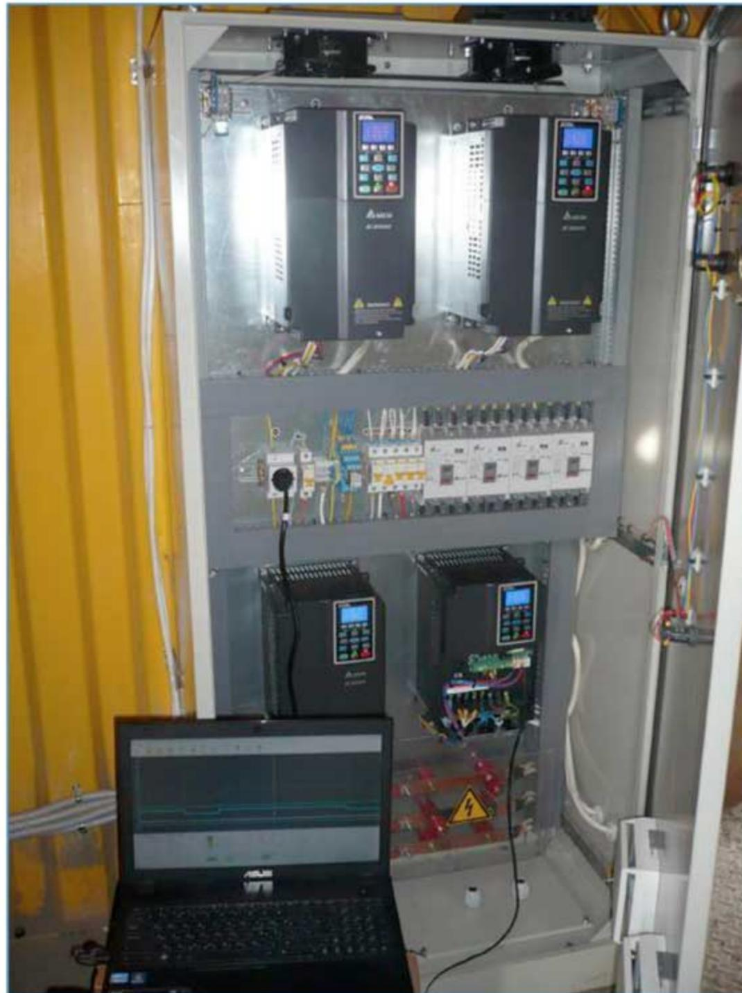
Преобразователи частоты VFD-C2000 в шкафу управления
