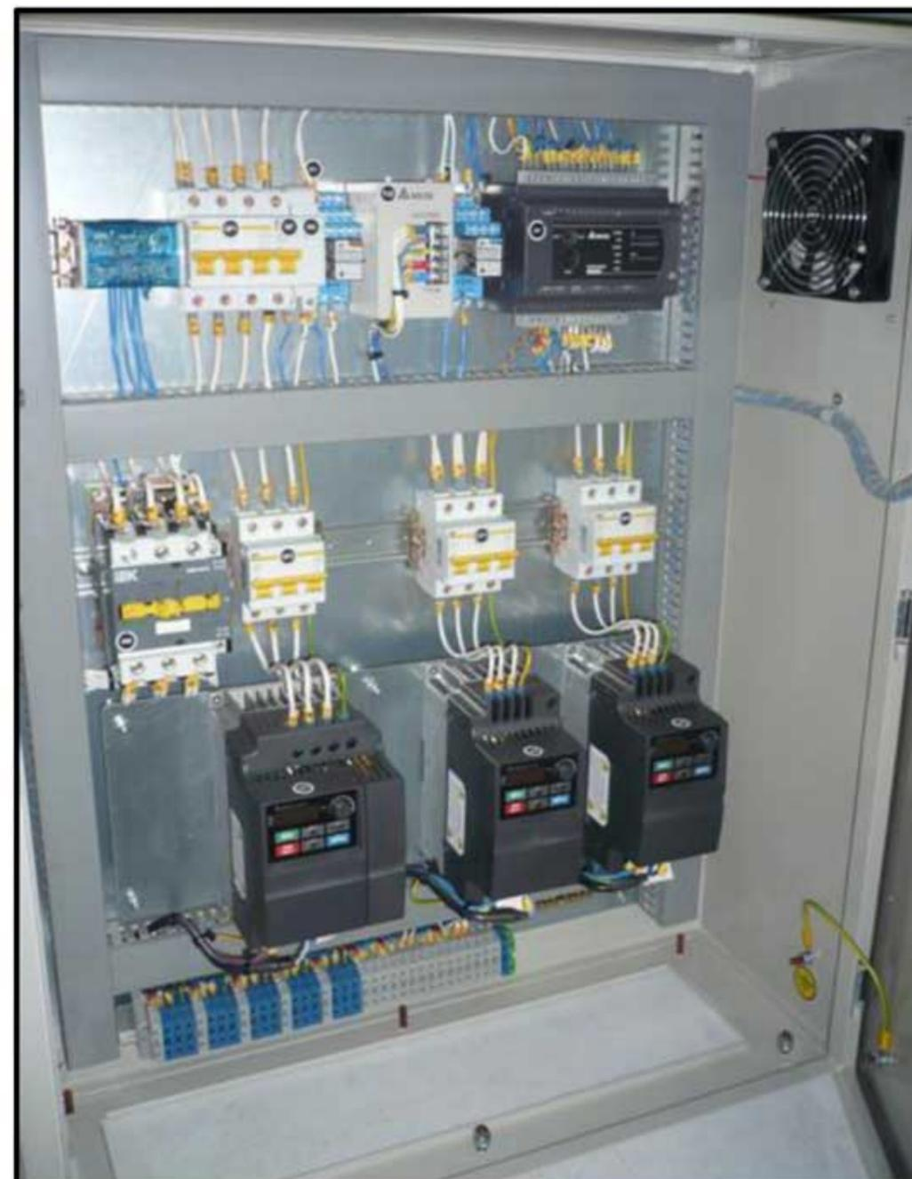
Оборудование Delta в шкафу управления (преобразователи частоты VFD-EL (3 шт.), ПЛК DVP-ES2, блок питания DVP-PS02, панель оператора TP04G-AL2)
