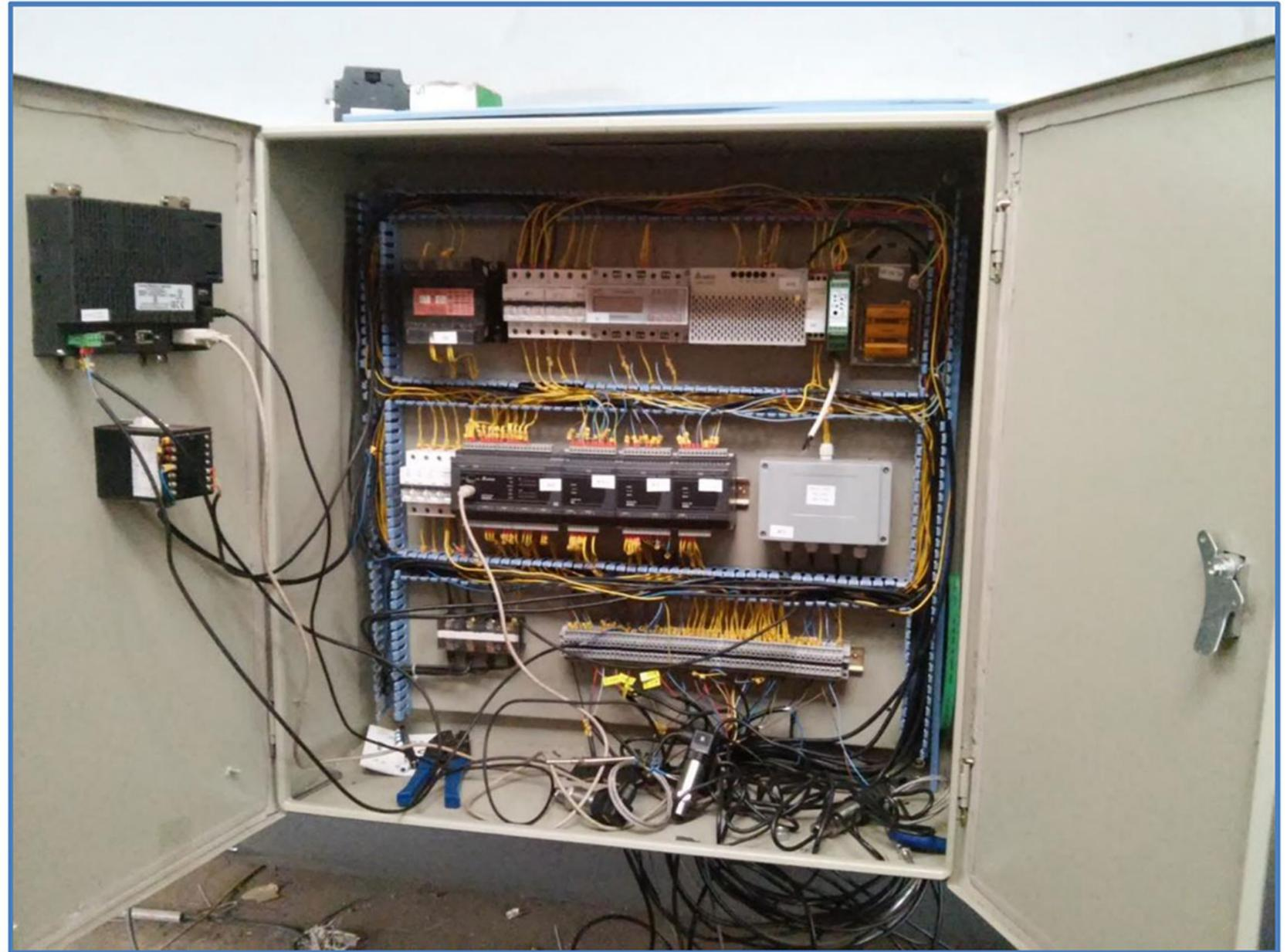
Шкаф управления, изготовленный местными специалистами. Панель оператора Delta Electronics серии **DOP-B**, ПЛК Delta Electronics серии **DVP-32ES2** с модулями расширения **DVP-04AD-E2 / 06AX-E2 / 04TC-E2**, блок питания для ПЛК **DVP-PS05**)
